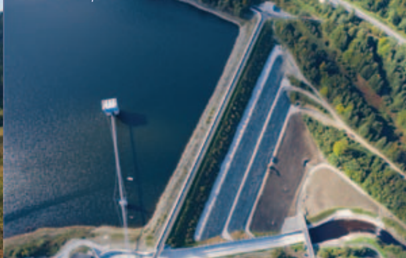
VD Šance - stav po rekonstrukci
