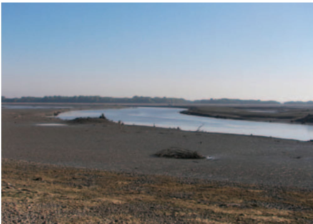
Obrázok 10. Pohľad na koryto Váhu vo vodnej stavbe Kráľová počas revízie v roku 2011
