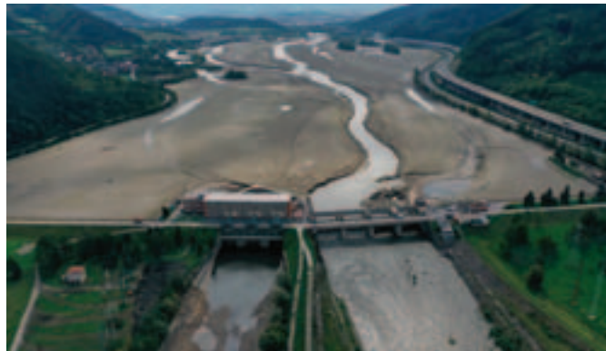
Obrázok 5. Záber na vodnú stavbu Hričov počas revízie, september 2019
