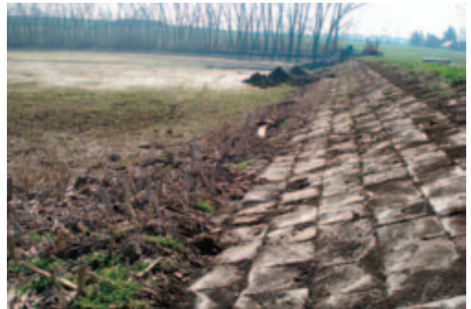
Obrázok 4. Zosuv dlažby návodného svahu
