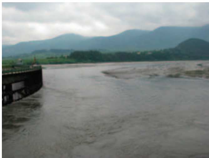
Obrázok 1. Sedimenty pred hrablicami vodnej elektrárne vodnej stavby Krpeľany
