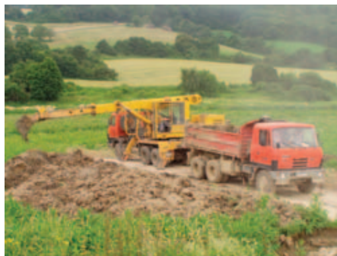
Obrázok 3. Odstraňovanie nánosov – prístupová cesta do sedimentačnej nádrže
