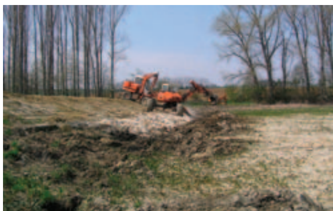
Obrázok 7. Stabilizácia päty dlažby záhozom
