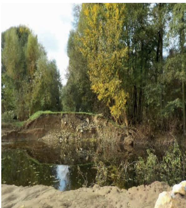
↓ Morava, ochranná hráz Lesnice po povodni...
