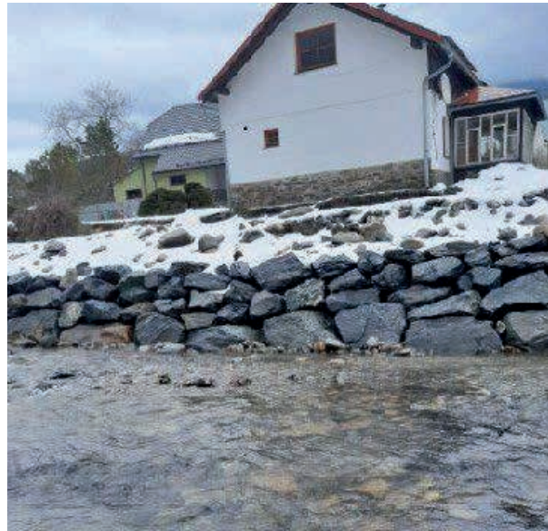
Aktuálně dokončené zabezpečovací práce na toku Desná, zajištění břehu u přilehlé nemovitosti ↑
