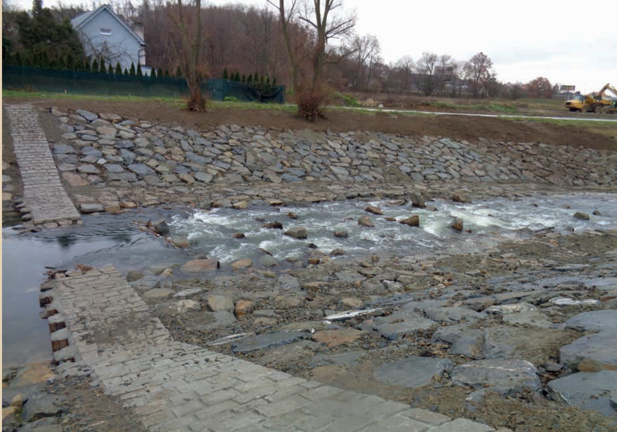
↑ Téměř dokončená rekonstrukce stupně na řece Dřevnici
