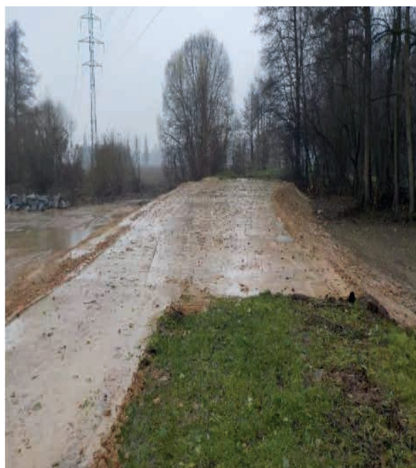
... a po zabezpečení ↓
