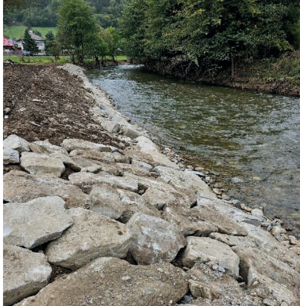
... a po zabezpečení ↑
